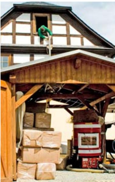
STEICOzell wird komprimiert, in Säcke verpackt, geliefert. Das verdichtete Fasermaterial wird in speziellen Einblasmaschinen aufbereitet und über flexible Rohre bis an den Verarbeitungsort geblasen. Der Vorteil: Die Maschine sowie das Dämmmaterial können außerhalb des Gebäudes gelagert werden, so dass zügiges Arbeiten auch in engen Räumen gewährleistet ist.
