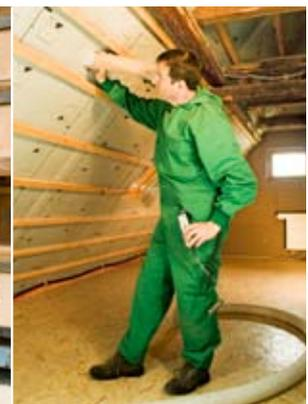
Bei der Dämmung mit STEICOzell spielt es keine Rolle, ob die Gefache auf gängige Dämmstoffgrößen abgestimmt sind. Auch Installationselemente in den Gefachen werden beim Einblasen ohne langwierige Handarbeit vollständig umschlossen. Durch die ausgereifte Technik beim Einblasen wird eine homogene und fugenfreie Füllung selbst bei kompliziertesten Konstruktionen erreicht.
